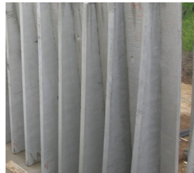
FRONTE IN AVANZAMENTO
