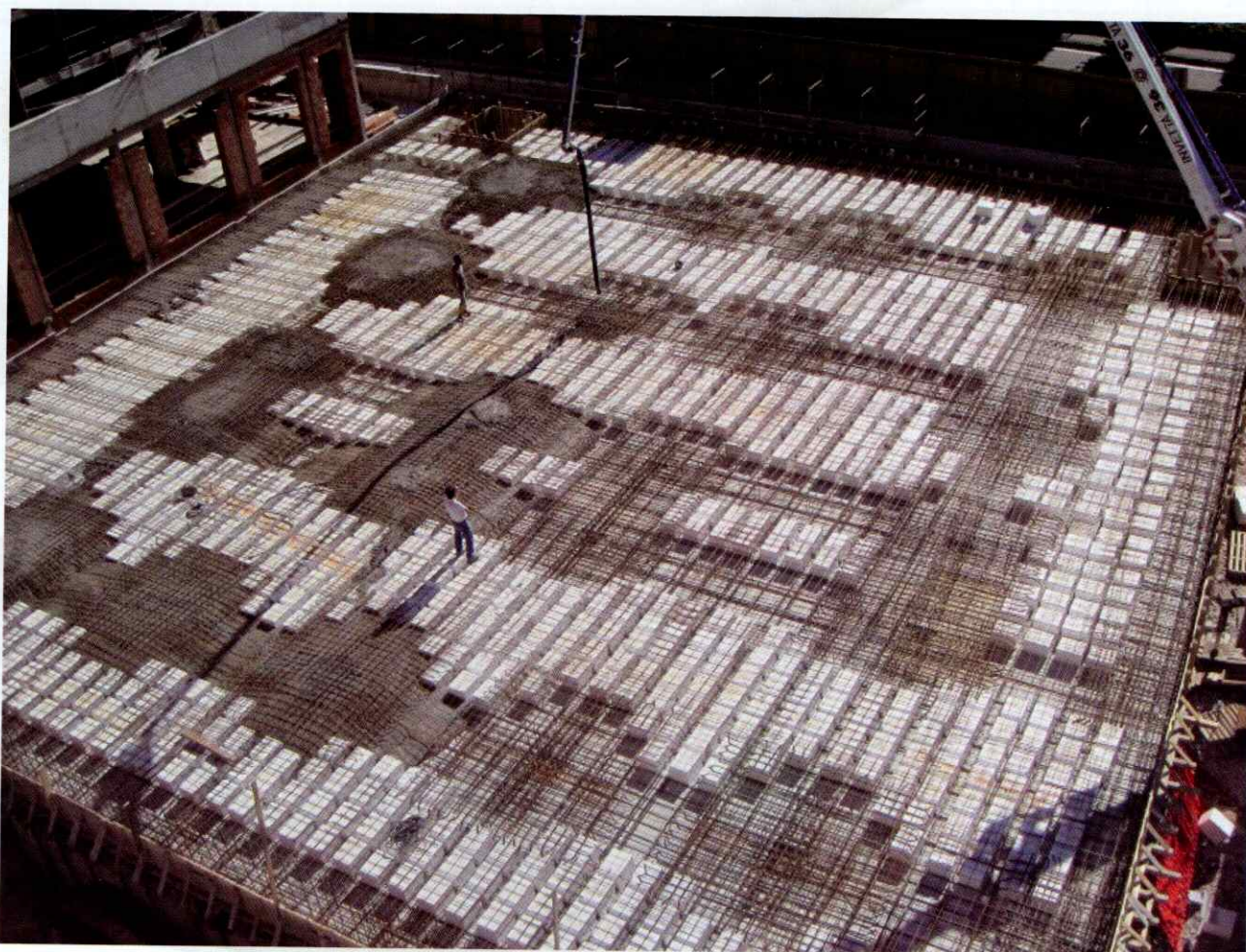
Lastre (predalles) per solai o impalcato da ponte
